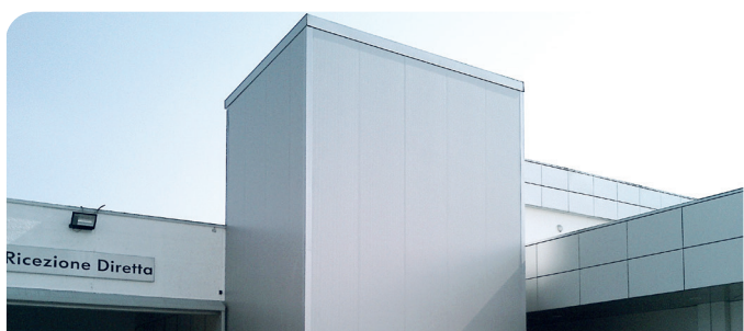
设备安装在室外
